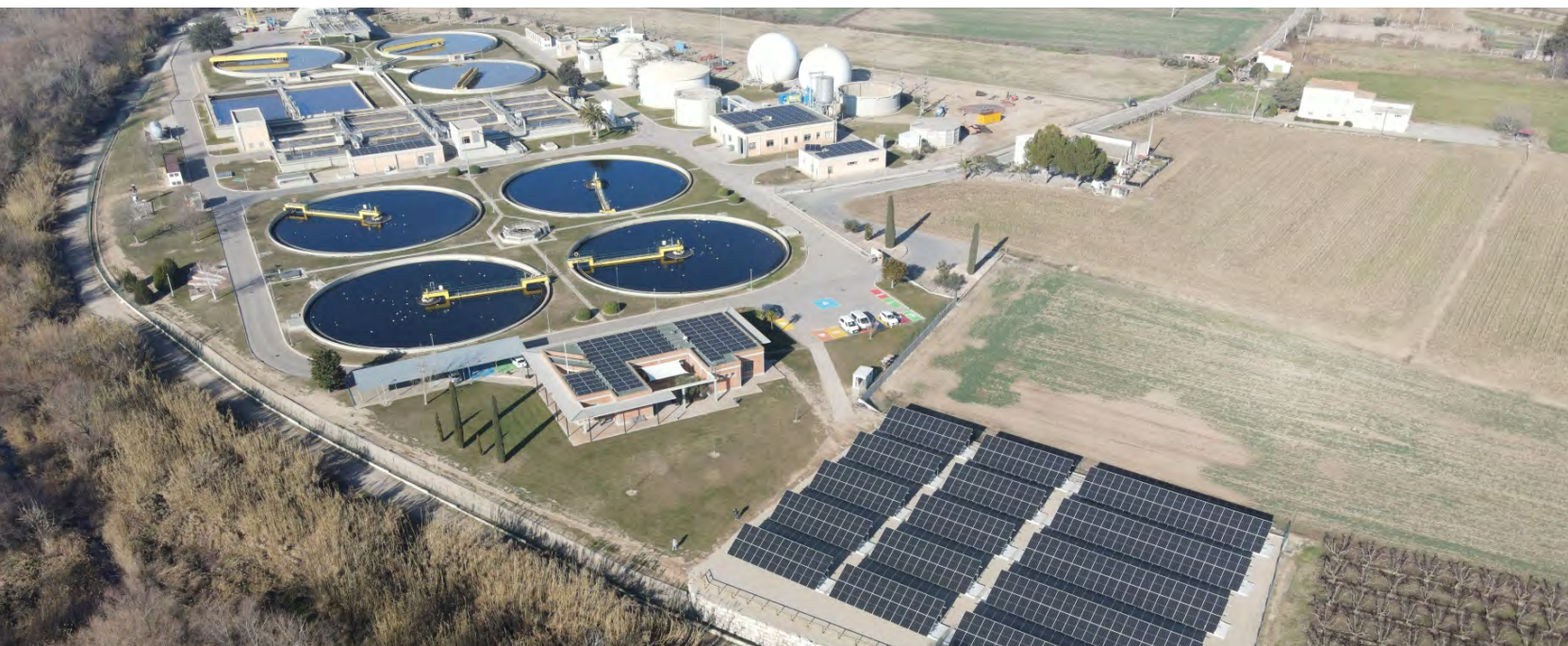
Instalación de placas fotovoltaicas en la Estación Depuradora de Aguas Residuales de Lleida.
