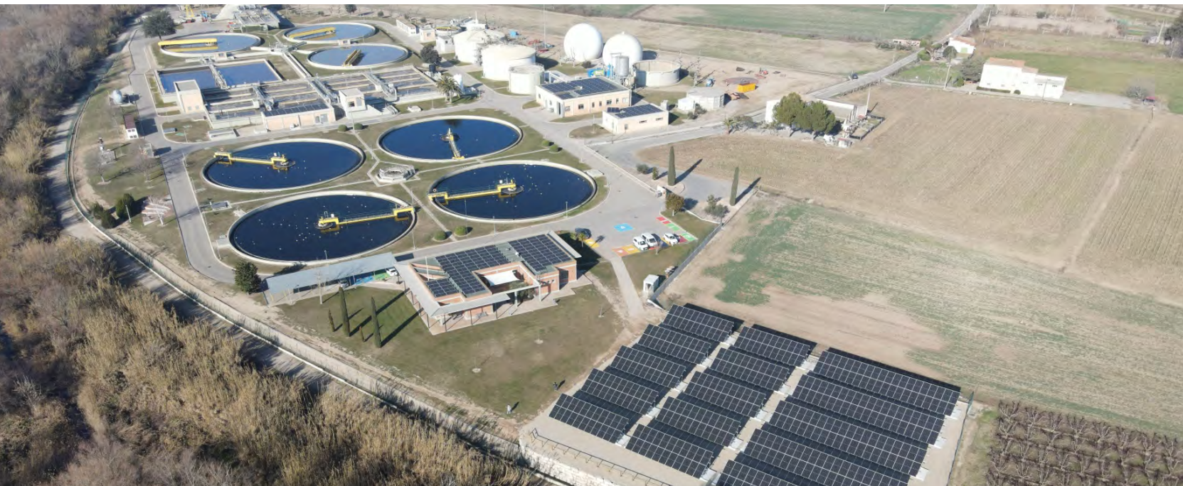
Instalación de placas fotovoltaicas en la Estación Depuradora de Aguas Residuales de Lleida.
